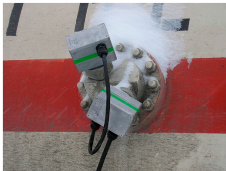
Монтаж датчика ДЖС-7Б.
