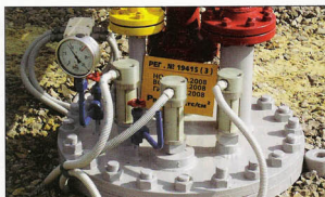
Рис. 5. Установка датчиков ДЖС-7 на резервуаре с СУГ
